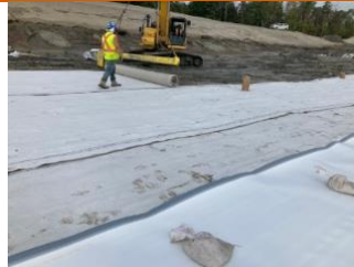
Photo : mise en place d'une membrane de protection (cellule 5B-4)
