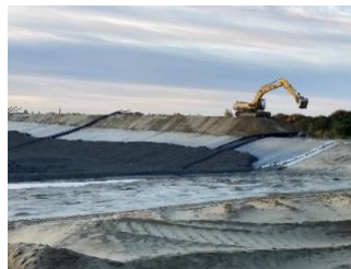
Photo : mise en place d'une membrane de protection
