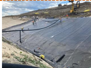
Photo : pose de membranes imperméables sur le toit des cellules
