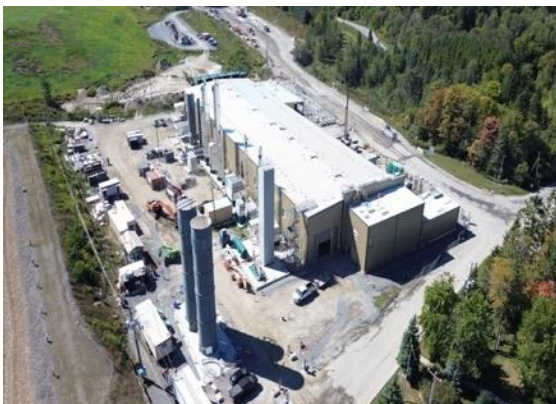
Usine de GNR en date de septembre 2025
