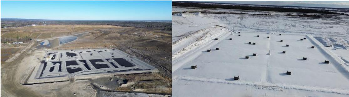
De janvier à mars 2024, l'excavation de la nouvelle cellule de la zone 6 (CET 3) de 3,4 hectares a été complétée. De mi-avril à septembre, le pompage et la gestion de l'eau se sont faits en continu. La membrane au fond de la cellule a été posée et il reste à installer la pierre et le gabion pour qu'elle soit opérationnelle. La mise en service de la CET 3 est planifiée pour 2025.
