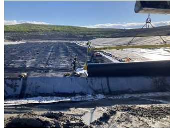
Photo : installation du système de drainage de la cellule 6-1
