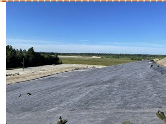
Photo : recouvrement final sur le talus sud de la cellule 5-B
