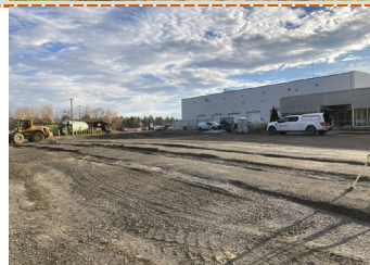
Photo : travaux d'aménagement du nouveau stationnement
