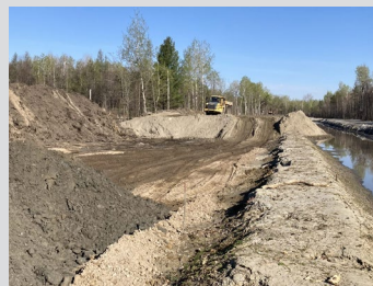
Photo : construction d'une berme de stabilisation
