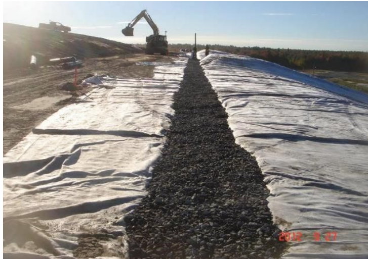
Réseau de tranchées horizontales
