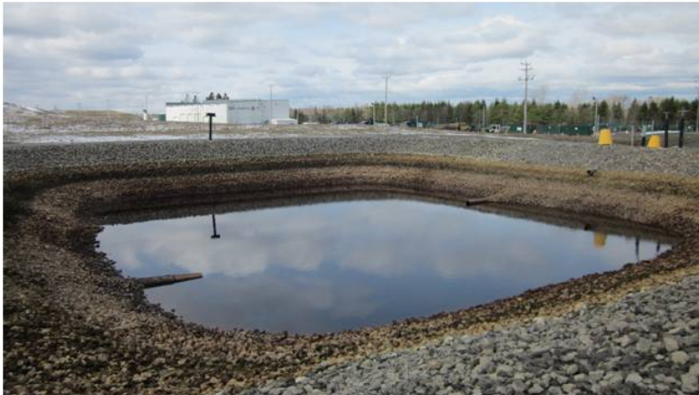
Bassin de polissage (1000 m 3 )
