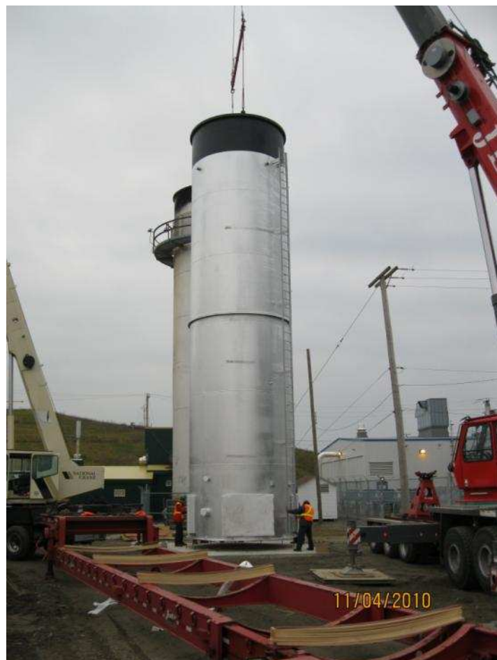
Mise en place de la nouvelle torchère (3)
