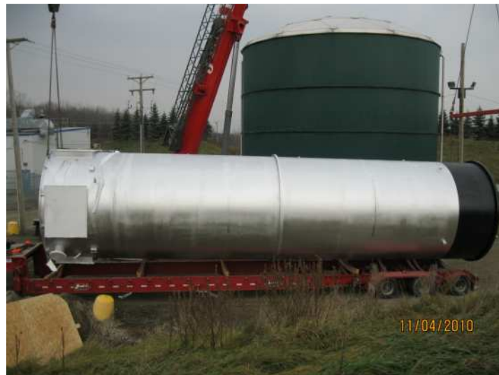
Mise en place de la nouvelle torchère (1)
