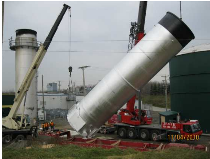
Mise en place de la nouvelle torchère (2)
